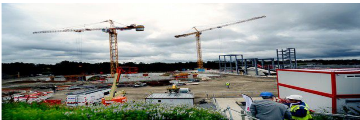
Illustration 1: La centrale de cogénération de Rennes en construction.
